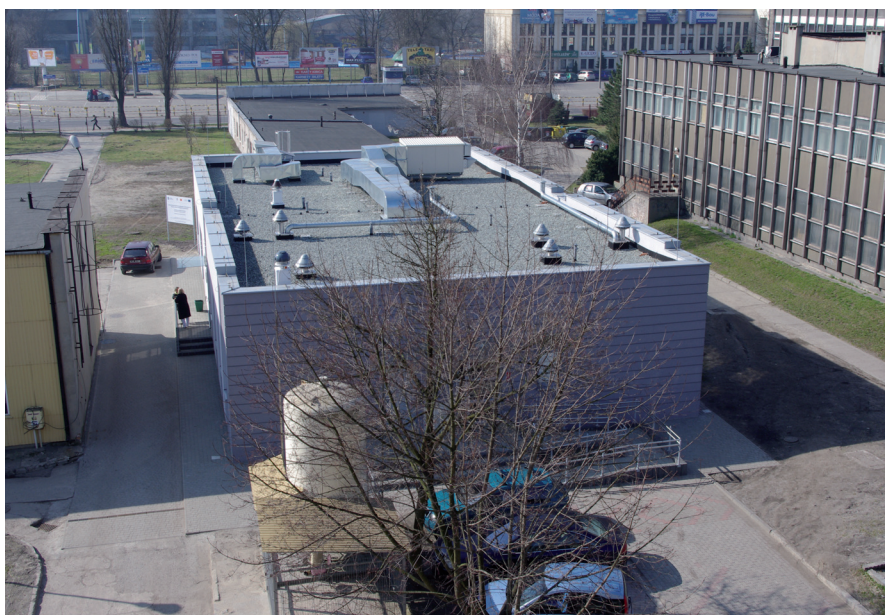
Fot. 2010/4. Zakończona budowa pawilonu Laboratorium Bionanotechnologii i Bio-diagnostyki (budynek U-5). Widok od strony wejścia oraz z górnego piętra pawilonu D-11 (Fot. A. Zięba)
